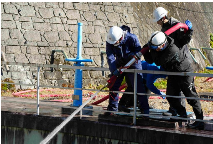
東俣浄水場清掃作業
