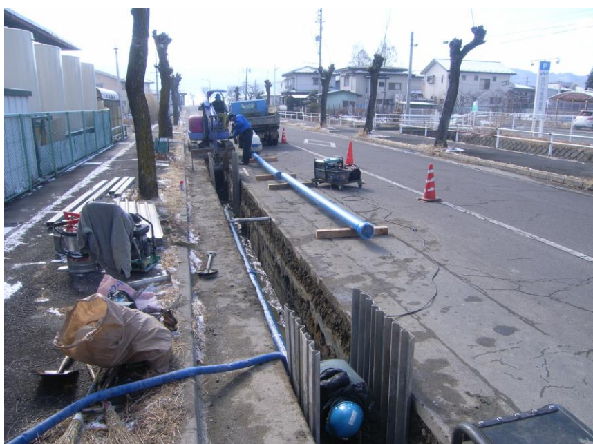
配水管布設替工事（南四王）
