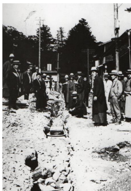
配水管埋設工事（大社通り 現すわのね前）
