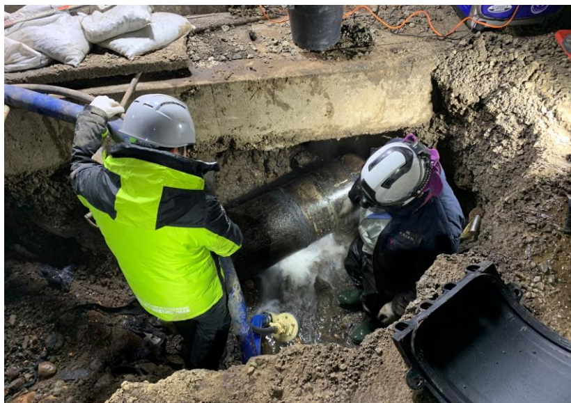
送水管漏水修繕工事（所沢団地付近）
