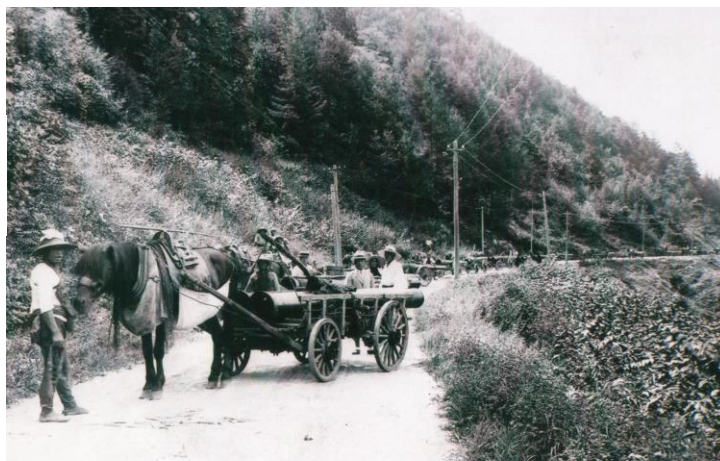
荷馬車による送水管 運搬（注連掛付近）
