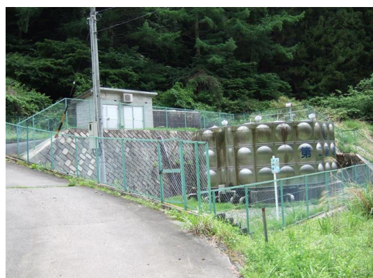
第2配水池（武居）
